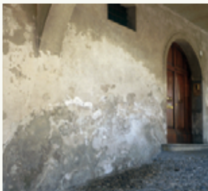
Figura 5 - Fenomeno dell'efflorescenza
