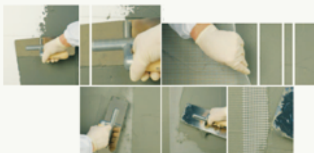
Figura 7 - Applicazione della rasatura armata
