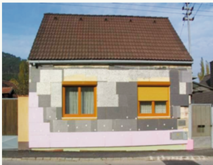
Figura 30 - Posizionamento in opera di pannelli isolanti di materiale diverso
