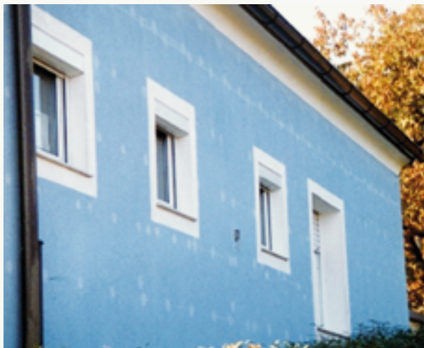
Figura 35 - Stuccatura delle teste
