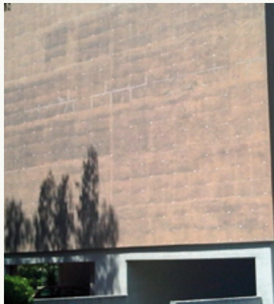
Figura 34 - Tassellatura applicata sopra il pannello
