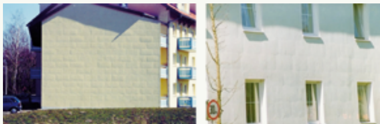
Figura 24 - Effetto materasso dovuto ad un cattivo incollaggio e/o mancanza di tassellatura
